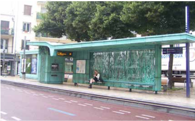
Figure 16 : La Station ouvragée «Cathédrale», à Rouen.
