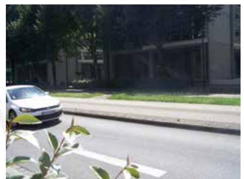
Figure 10 : Le site propre surélevé du Busway de Nantes (Pierre DUHAMEL)
